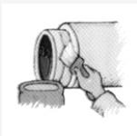
Una tensión desigual o una alineación inadecuada de la goma puede desalojar la junta, causar fugas e incluso romper la campana.
